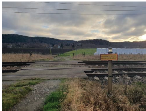
Figur 1. Exempel på en bevakad plankorsning. Texten på skylten i bilden ovan: "PASSERA EJ SPÅRET NÄR LAMPAN ÄR SLÄCKT".
