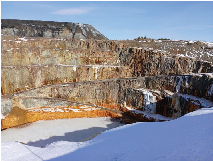
Figur 11. En av de uttjanta öppna gruvorna i Maurliden som ska bli föremål för efterbehandling/återfyllnad.
