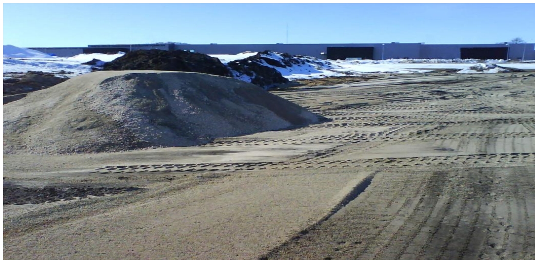
Bild 9. Utfyllnad med bentonitbunden formsand för byggnation av köpcentra.
