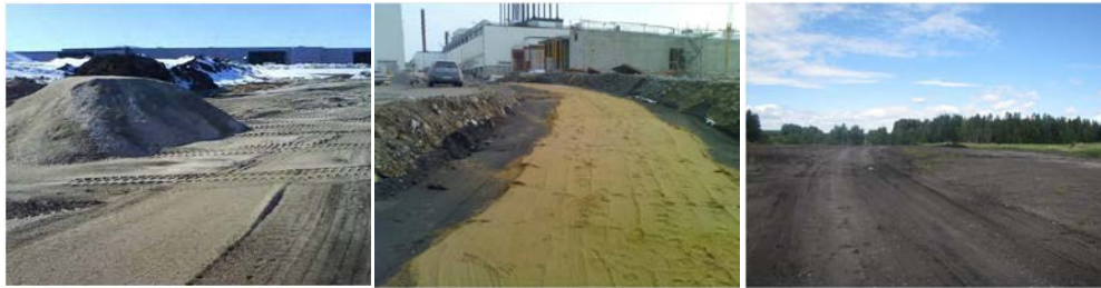
Bild 3 Extern återvinning av gjuterisand. T v: Utfyllnad med gjuterisand och kupolugns-slagg från Volvo i Skövde. Mitten: Gjuterisand i rörgravar hos Scania i Södertälje. T h: Utfyllnad med sand från Arvika gjuteri
