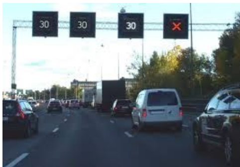
Figur 6. MCS med dynamiska skyltar på Essingeleden i Stockholm. Skyltning av avstängt körfält och lägre hastighet på grund av olycka.
