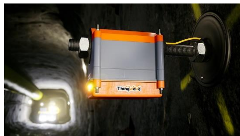
Figur 21: smart bergbult monterad i bergvägg
