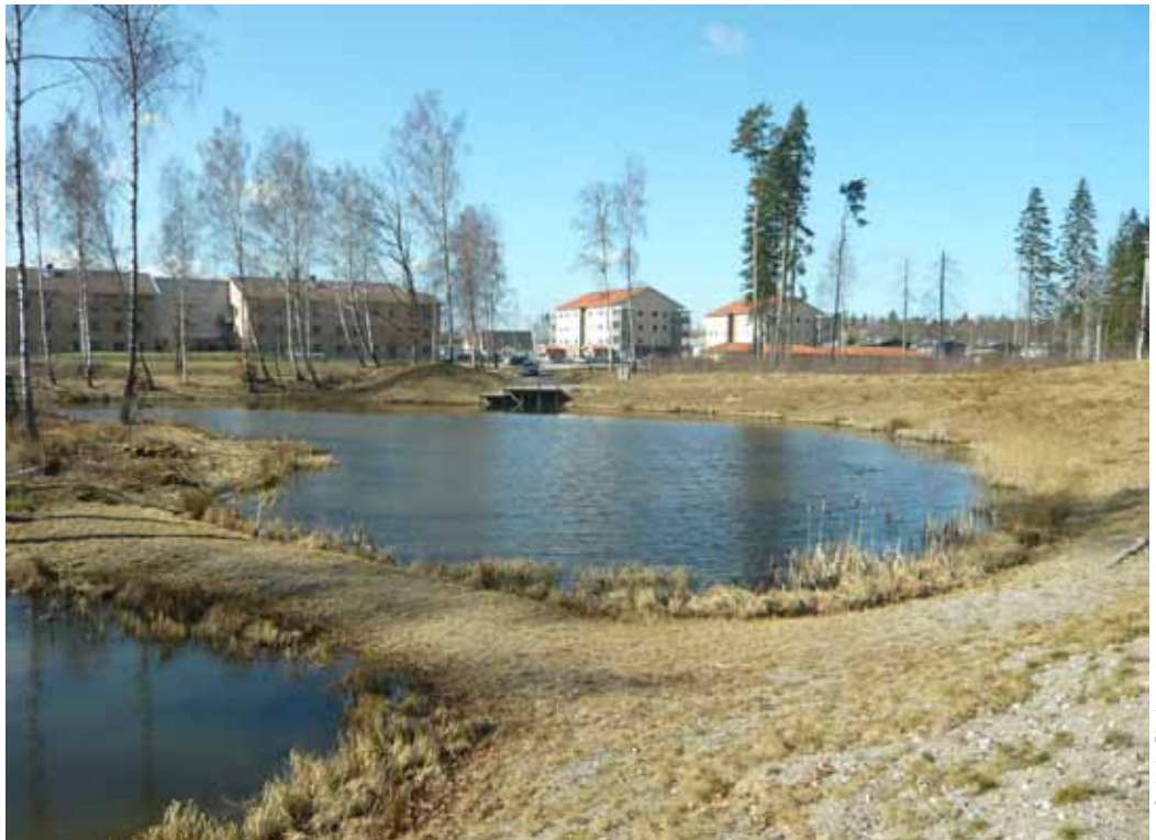
Födröjningsmagasin i Växjö.
