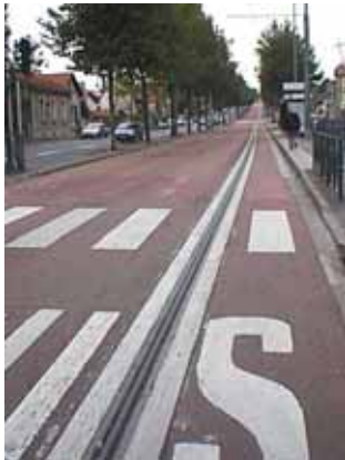
Närbild av busskörfältet med mitträl i ena riktningen vid Trans val de Marne.
