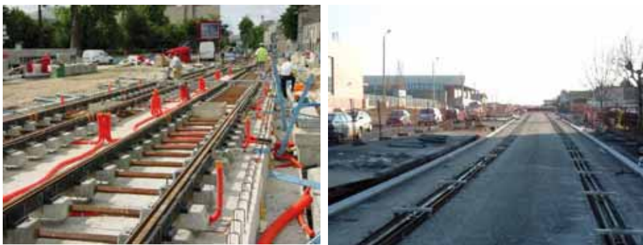
Spårväg med slippers och gaturäler till vänster, Translohr-bana till höger
