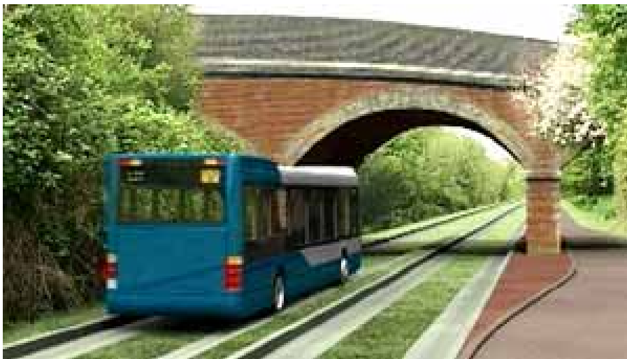
Fotomontage, dubbelriktad bussbana på befintlig järnväg. Illustrationen visar på möjligheterna att utnyttja O-bahn teknikens smala utrymmesbehov
