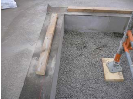
Monterad styrssyll, synligt mögel
